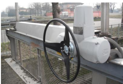
Kit di emergenza su Att. Elettrico BIFFI
