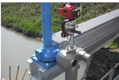
Attuatore APB/APS su Att. Elettrico AUMA
