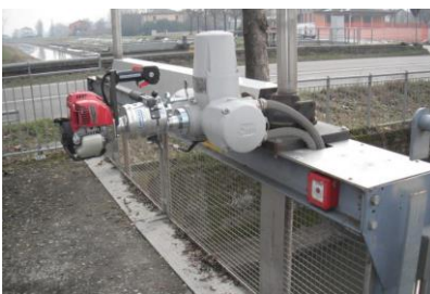
Attuatore APB/APS su Att. Elettrico BIFFI
