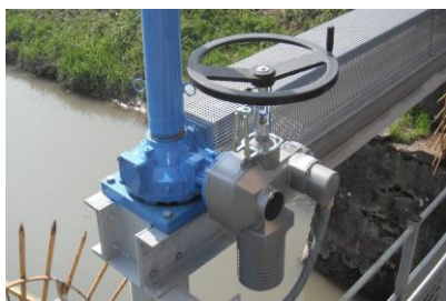
Kit di emergenza su Att. Elettrico AUMA
