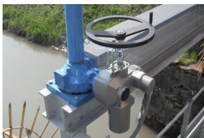
Kit di emergenza su Att. Elettrico AUMA
