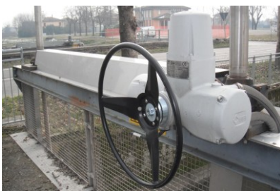
Kit di emergenza su Att. Elettrico BIFFI
