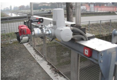
Attuatore APB/APS su Att. Elettrico BIFFI
