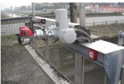
Attuatore APB/APS su Att. Elettrico BIFFI
