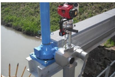
Attuatore APB/APS su Att. Elettrico AUMA
